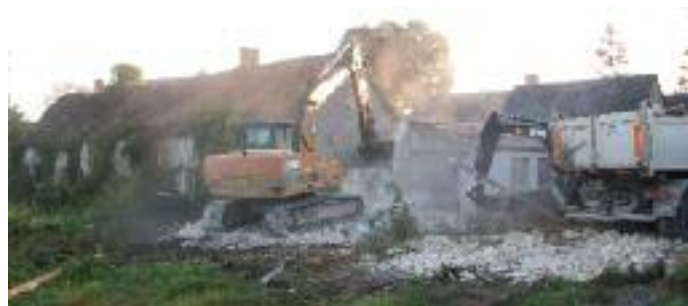
Une ancienne maison et un bâtiment très vétustes sont rasés.
